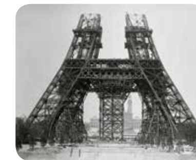
La Tour Eiffel in costruzione (1887-1889).
